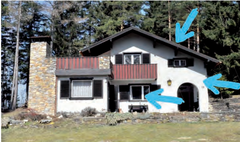
Planer und Foto: aap.architekten ZT GmbH
